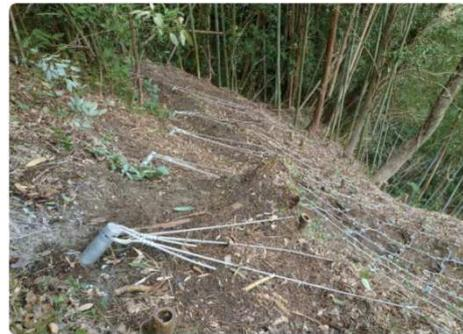
ワイヤーネットとアンカーピンだけで転石郡の安定が保たれない場合は、安定した岩盤に定着させる深層アンカーを用います。
