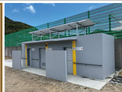
トイレ棟、太陽光パネル
