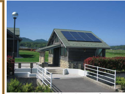
トイレ棟、太陽電池
