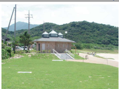
トイレ棟と処理装置（手前）
