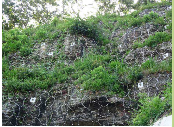
深層アンカー+ワイヤーネット(岩盤崩壊対策)
