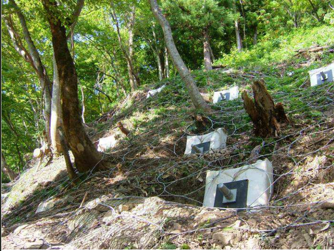
グラウンドアンカー+ワイヤーネット(土砂崩壊対策)
