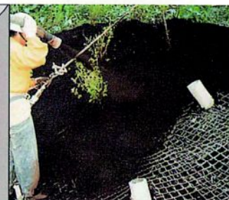
2. 植生基材吹付け施工と植栽
