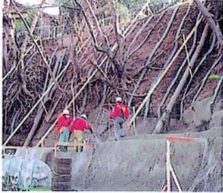
1. 施工前（経年的浸食状況）
