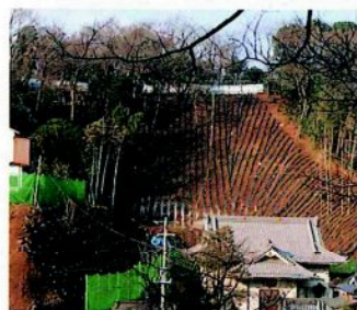
2. 連続繊維補強土の築造
