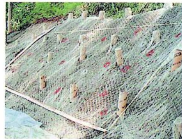
1. 連続繊維補強土築造後の金網張り
