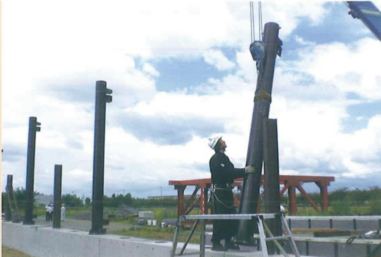
支柱建て込み工
