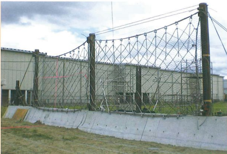
ワイヤーメッシュパネル設置工
