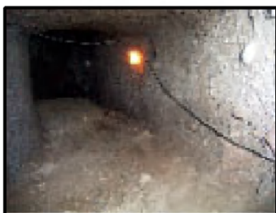
特殊地下壕・廃坑の充填
