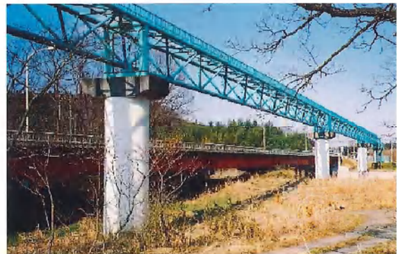
【水管橋の補強】
