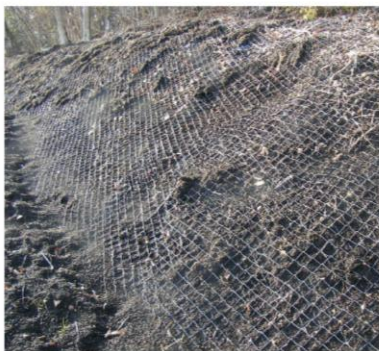
植生基材吹付工
