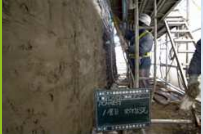
6 ポリマーセメントモルタル吹付け状況
