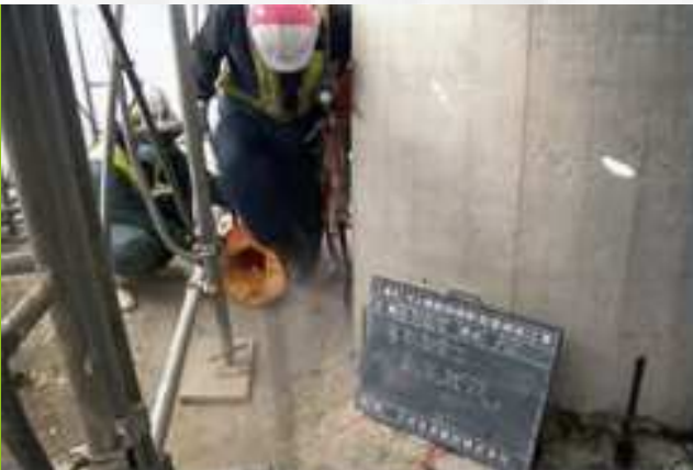
3 基部削孔状況
