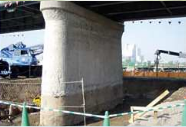
1 既設橋脚現況
