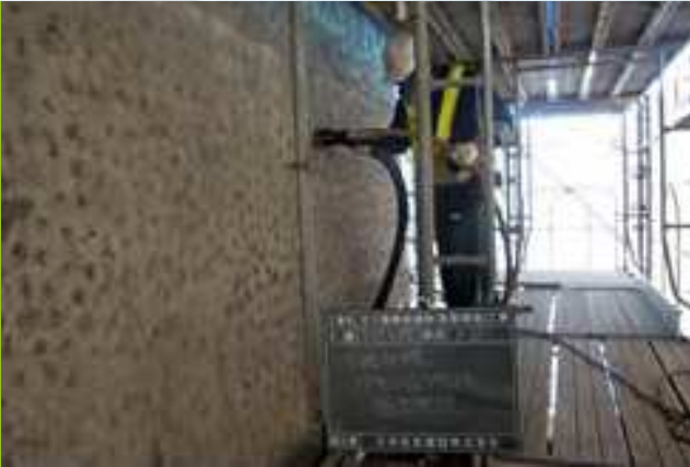
2 下地処理状況 (バキュームブラスト)
