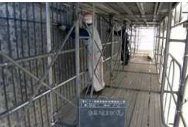
4 補強鉄筋組立状況
