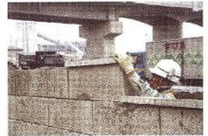
目隠しプレート取付
