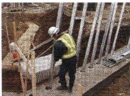
支柱建て込み
