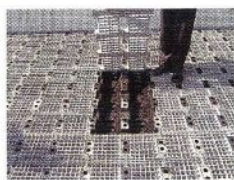
スペーサー設置
