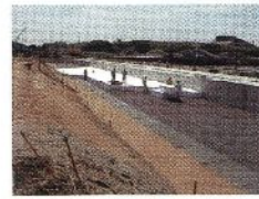
EPS設置作業
