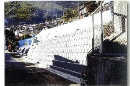
道路拡幅盛土
