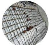
飛来ステーションは、従来の平面的なネットとは大きく異なり、立体構造のネットを使用しています。さらに、ネット目合いを大きくしたこと、飛来種子の捕捉能力が飛躍的にアップしました。飛来ステーションは、飛来種子捕捉能力を高くしたことで、周辺からの植生誘導効果が望めます。
