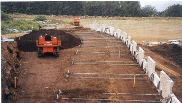
施工実験の全景
