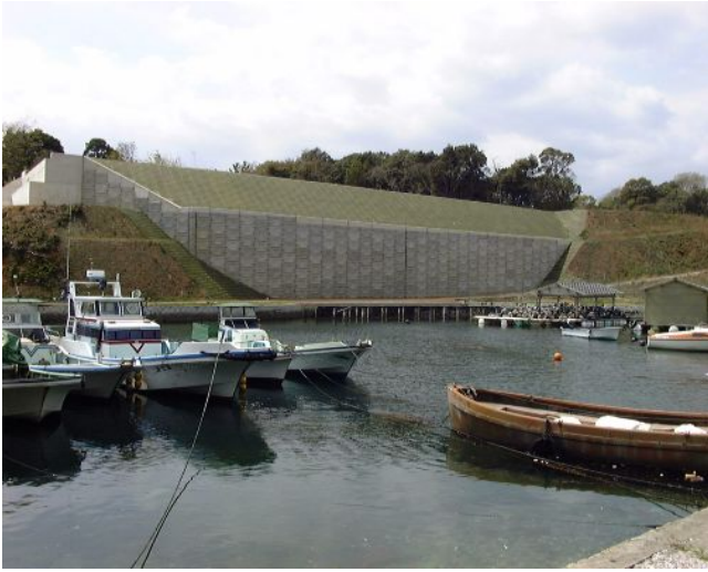
三重県志摩建設事務所 一般国道260号志摩工区
