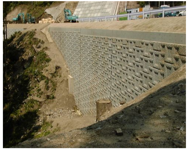
水資源機構 川上ダム建設所 付替県道松青線
