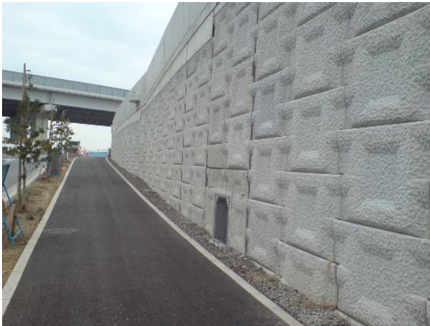
国土交通省 中部地方整備局 北勢バイパス 広永道路整備工事
