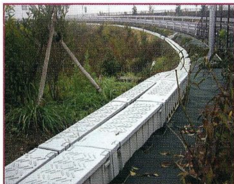
ケーブルダクト
