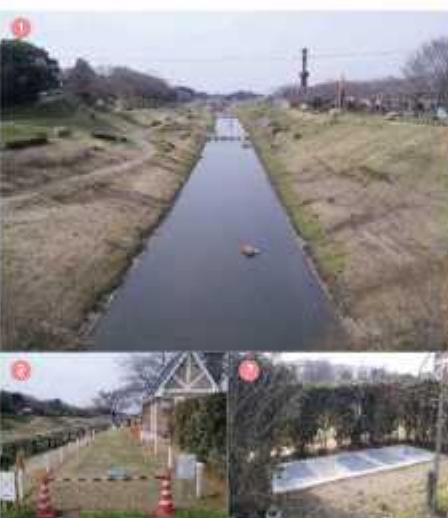
① 利根運河 ② トイレ設置、太陽光発電設備 ③ 一次処理槽
