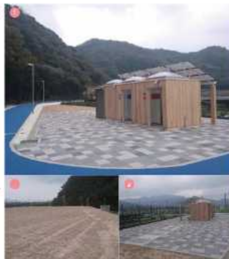
① トイレ設置、太陽光発電設備 ② 太陽光発電設備 ③ トイレ設置、一次処理槽
