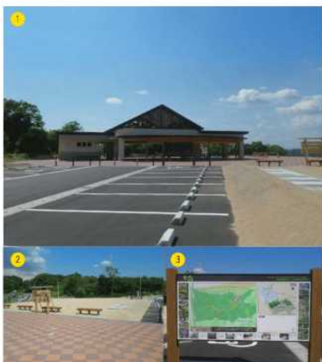
1 トイレ建屋 2 処理装置 3 案内板
