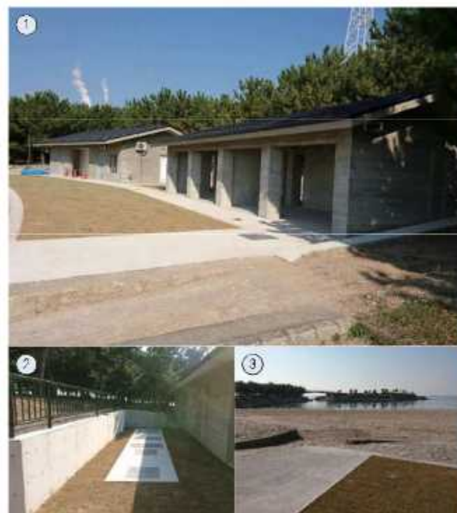
① トイレ建屋
