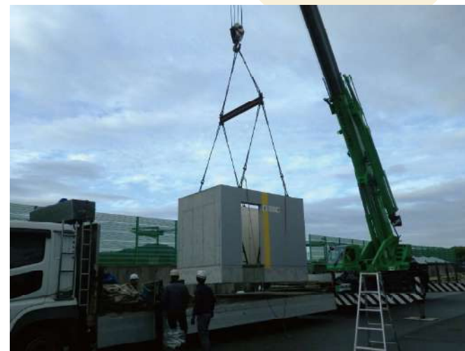
トイレ搬入状況
