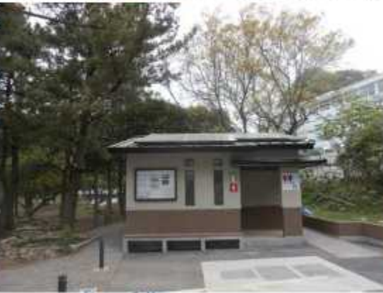
◀ トイレ建屋と一次処理槽(手前)、土壌浸潤槽(右側)
