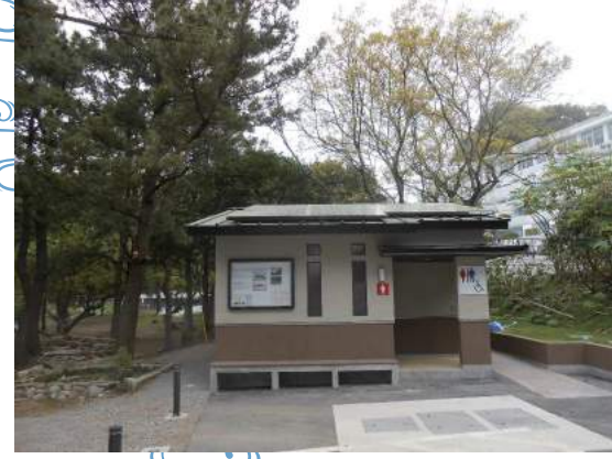
◀ トイレ建屋と一次処理槽(手前)、土壤浸潤槽(右側)
