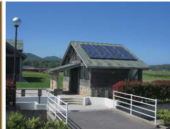
トイレ棟、太陽電池
