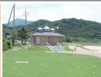
トイレ棟と処理装置（手前）
