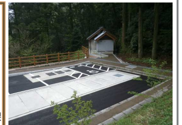
処理装置（手前）、トイレ棟
