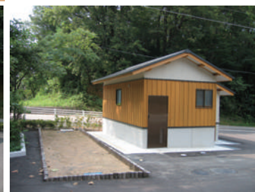
土壌浸潤槽、トイレ棟
