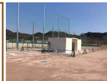
トイレ棟、処理装置
