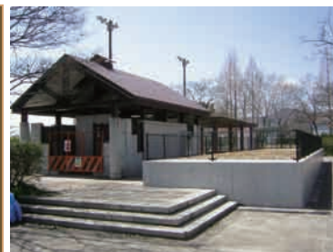
トイレ棟、土壌浸潤槽
