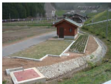
トイレ棟、処理装置
