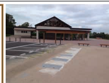
トイレ棟、一次処理槽
