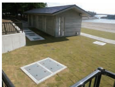
処理装置、休憩棟
