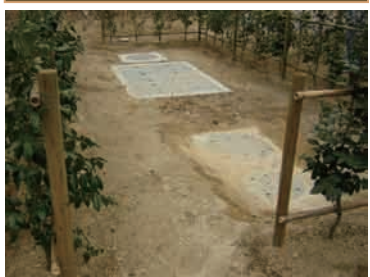
一次処理槽と消毒・貯留槽
