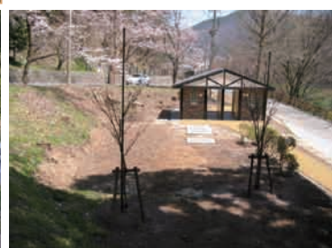
トイレ棟と装置全景
