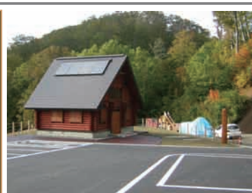
トイレ棟、太陽電池装置
