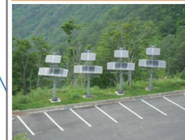
太陽電池装置
