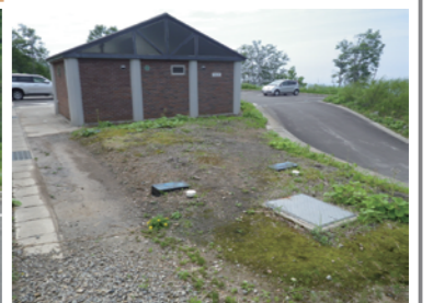
処理装置(手前)、トイレ棟
