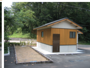
土壌浸潤槽、トイレ棟
