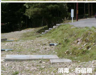
消毒・貯留槽
